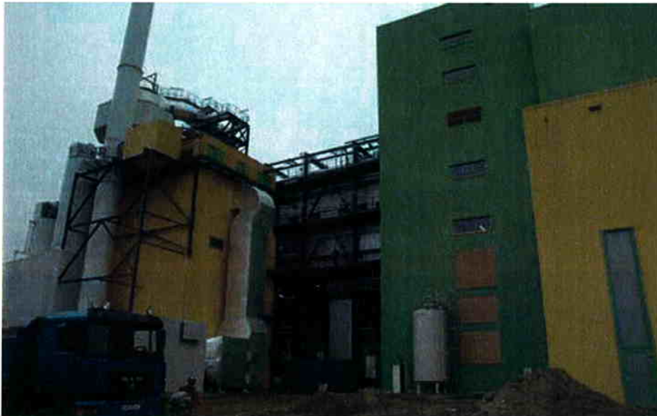
Neues EBS-Kraftwerk in Stavenhagen
